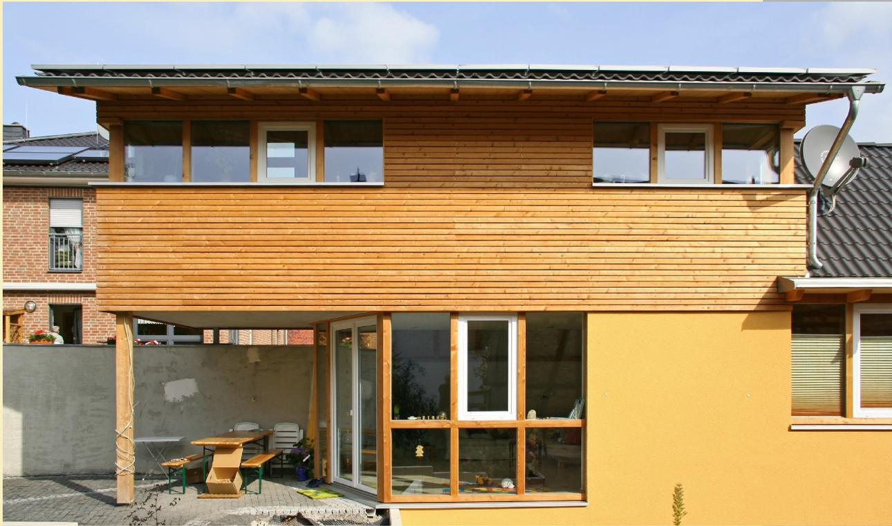
Abb.: Blick aus Hof auf Obergeschoss : Holzbau, mit Lärchenschalung
