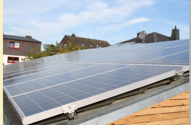
Abb.: PV- Anlage auf dem Dach : 61 m<sup>2</sup> mit 7,59 Kwp.
